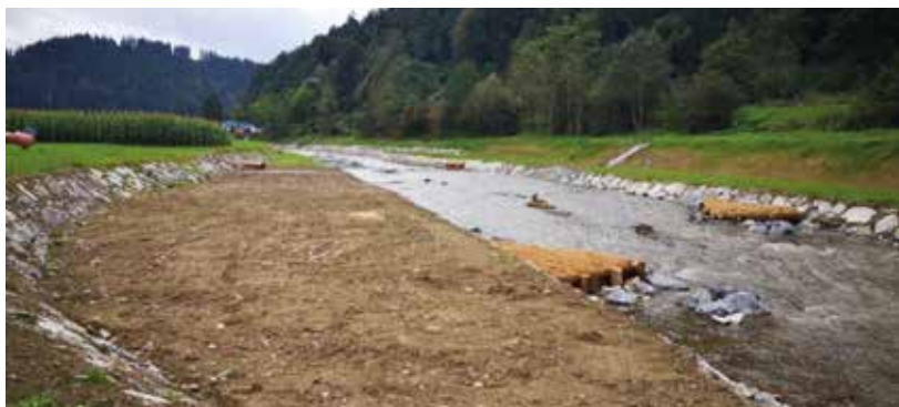
Slika 1: Odsek Mislinje v Pamečah, kjer je bila zagotovljena dodatna razlivna površina, kamor se lahko v času visokih voda reka nadzorovano razlije. V času nizkih voda je polna le osnovna struga. (Petra K. Marhold)
